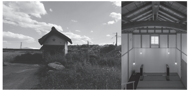
図-6 津波に耐えて残った蔵と改修後の蔵(希望の蔵)の状況
